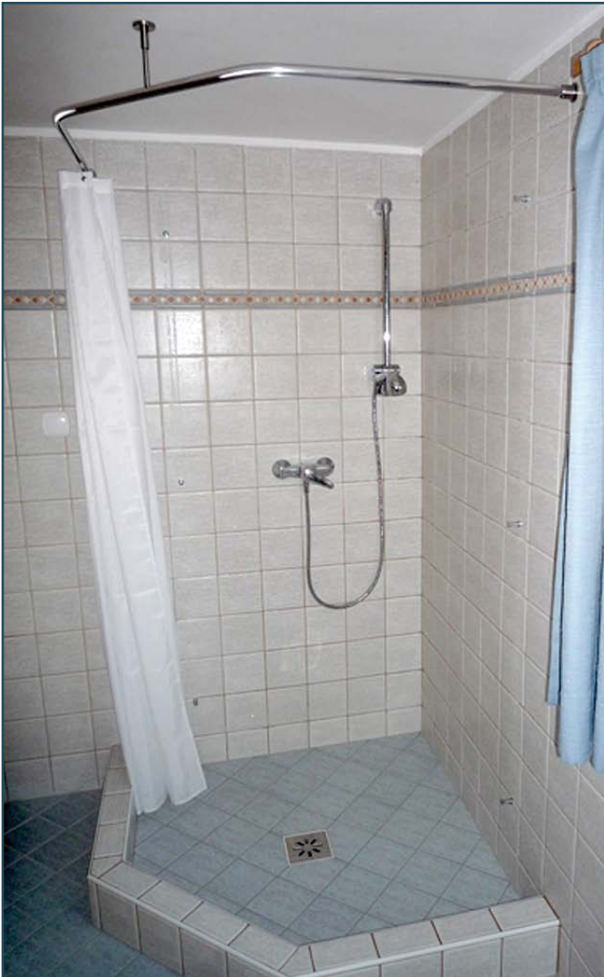
Wand- und Deckenbefestigung, Duschwanne
